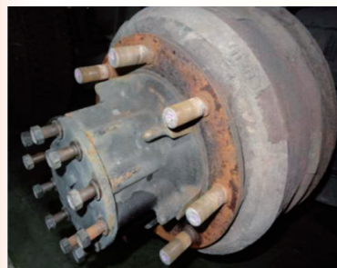
ハブのディスク・ホイール当たり面には、著しいさびが発生
